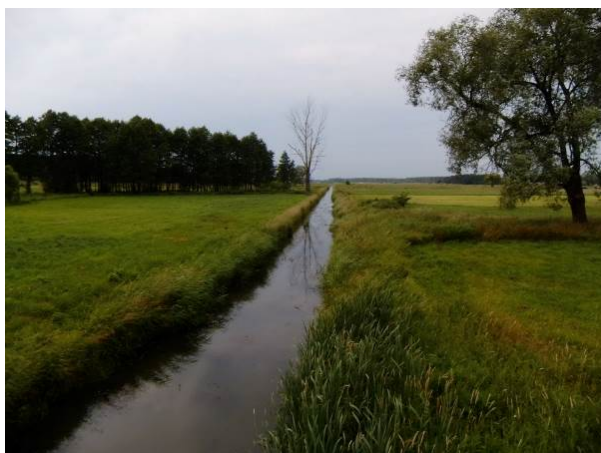
Płodownica - kiedyś rzeka, dziś kanał odprowadzający ścieki
