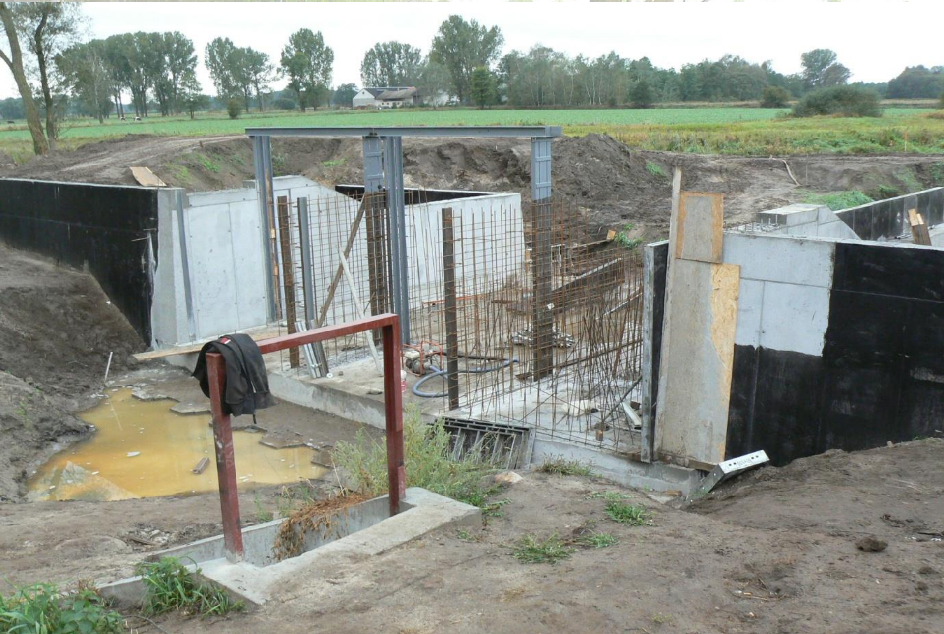
Budowa jazu piętrzącego dla zbiornika wodnego Góra Bałdrzychowska
