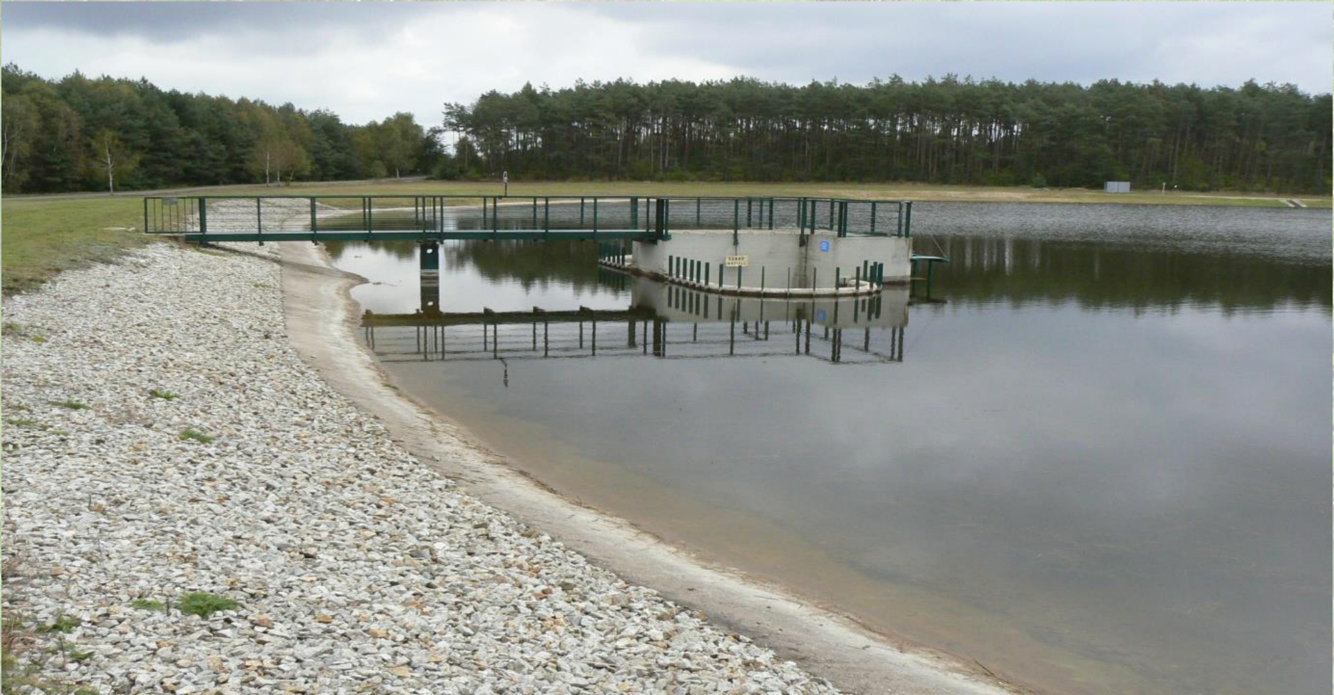
Budowla piętrząca zbiornika „Próba” na rzece Żeglina
